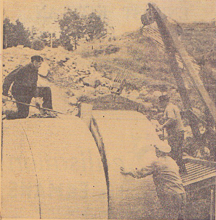
här arbetar tre av Botjärnsborna med de stora kulvertringarna.
