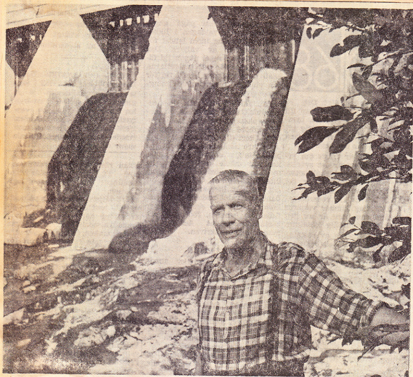
Maskinist Johan Liebenholtz framför Djupdals kraftstation.
