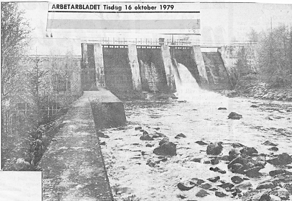
■ Djupdals kraftstation ökar sin kapacitet när två av de tre turbinerna tas i drift efter re- novering. Foto: Hans Wandér
