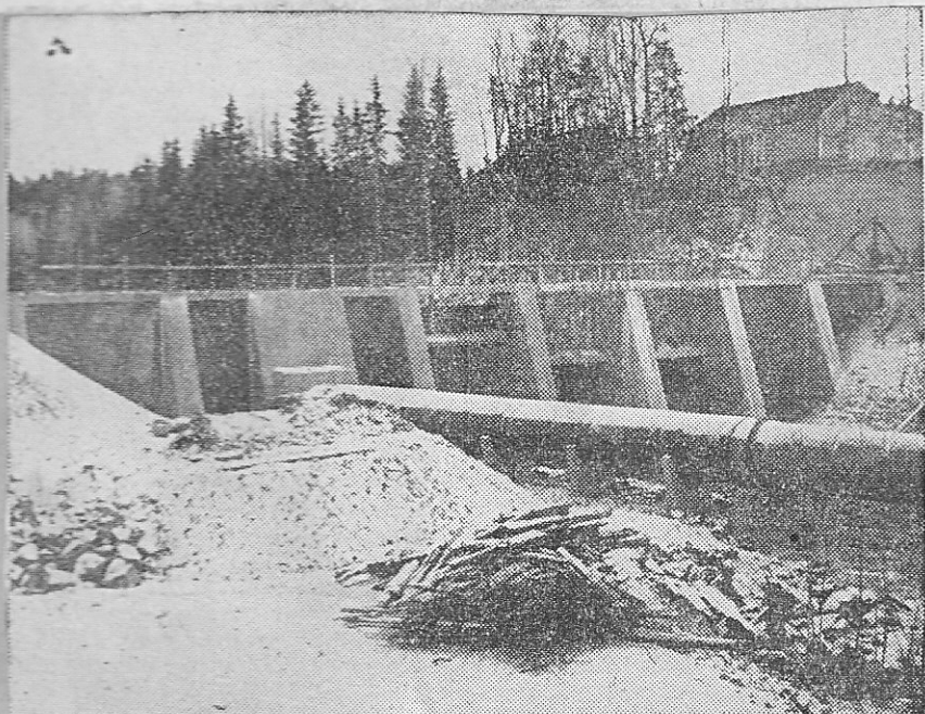
Den kraftiga betongdammen vid Kungsfors kraftstation med en del av den 350 m. långa vattentuben.
