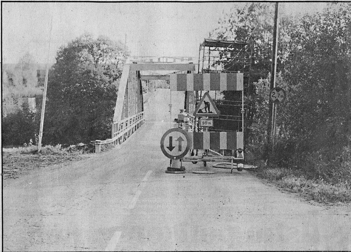
● Hela sommaren har passerandet av bron mot Ockelbo vid sägen i Järbo varit ett problem. Särskilt för långträdare och andra tyngre fordon.
