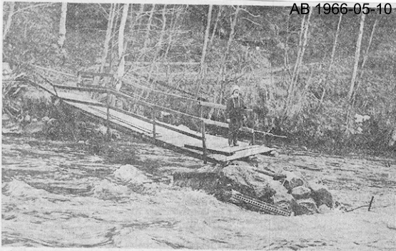
Gångbron över Jädraån nedanför Järbo sågverksförenings kraftstation har blivit hårt åtgången av vårfloden.
