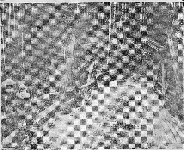
Den sk Stoppbron skall nu rivas, sedan ingen längre vill underhålla den.
