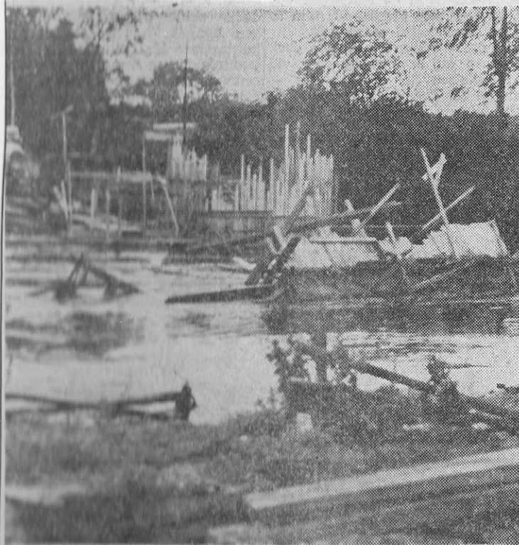
Vattenmassorna har tagit mellanstödet i mitten av ån och träställningen vid norra landfästet.
