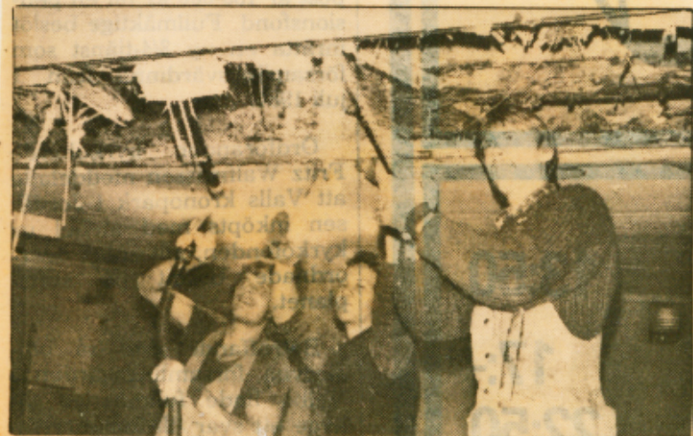
■ Än kan det dröja många år innan ett nytt Folkets hus byggs i Järbo. Under tiden måste taket i den gamla biograf-lokalen lagas. Per Eriksson, Sandviken, Lennart Myrefors, Järbo och Mikael Nyman, Sandviken spettar så spånen yr.
