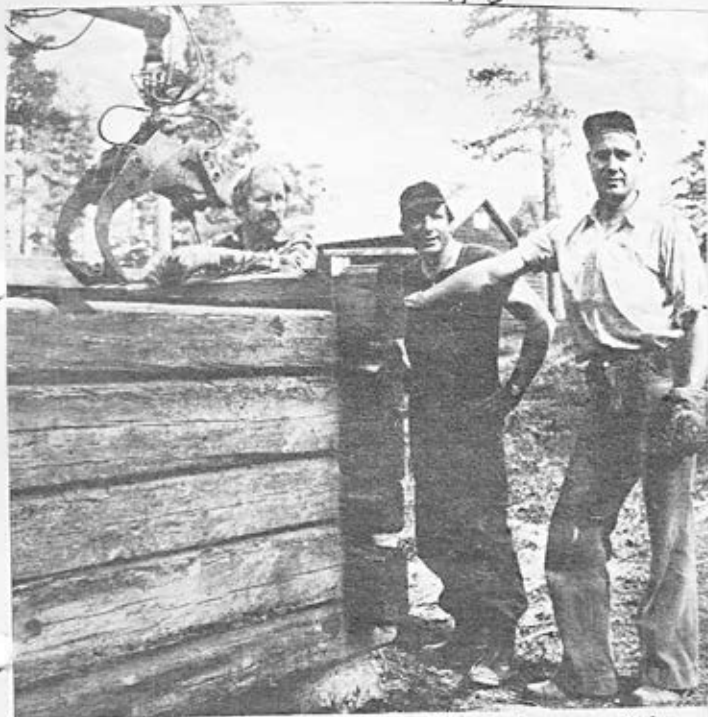
■ Bengt "Putte" Bergström, Järbo, Stig Andersson, Järbo och Lars Persson, Hofors under arbete med att bygga upp den finska bastun, som hämtats från "Kammars" i Finnäs, Järbo och införlivas med de övriga byggnaderna vid Järbo Hembygdsgård.
