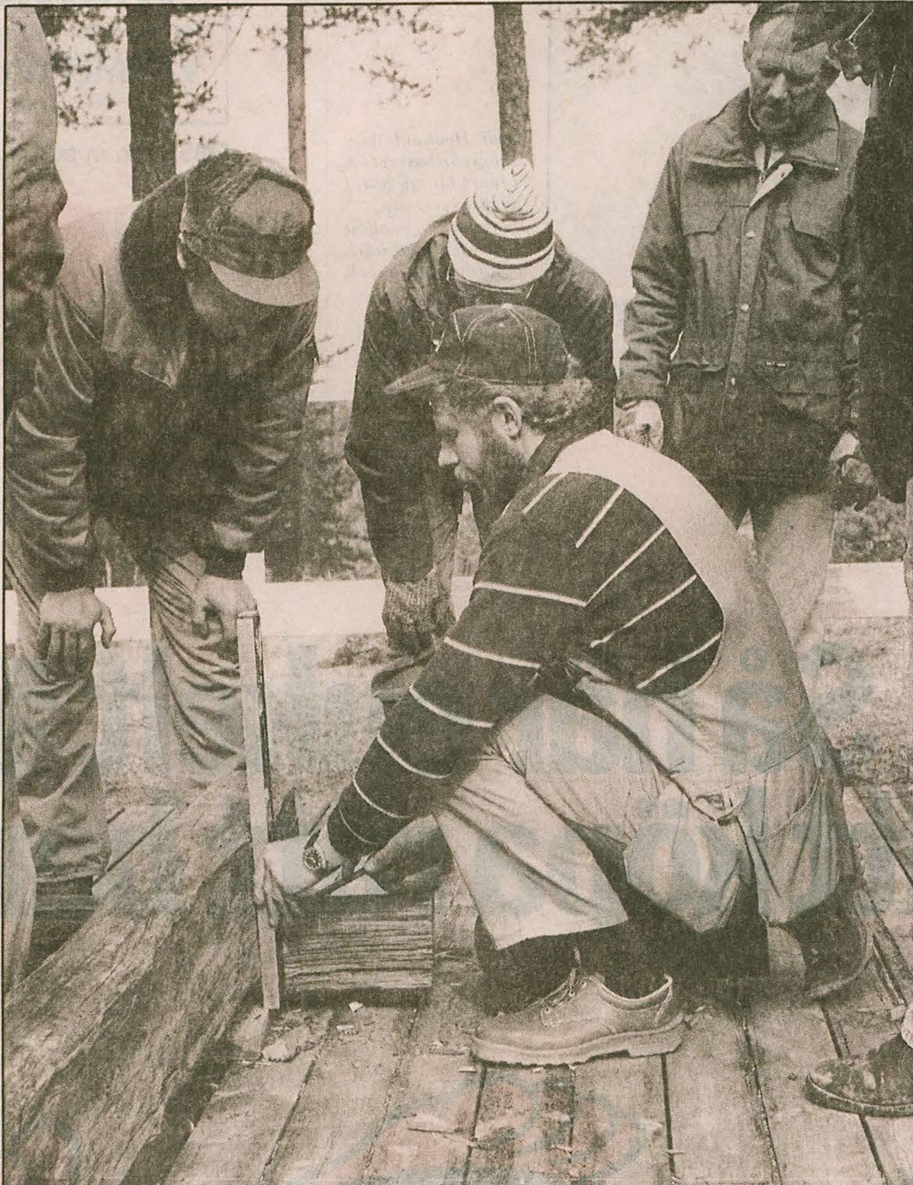
Knutning av timret drog till sig största intresset. Kursledaren Bo Eliasson visar hur man med hjälp av vattenpass får rätt vinkel för nästa stock vid knutningen.
