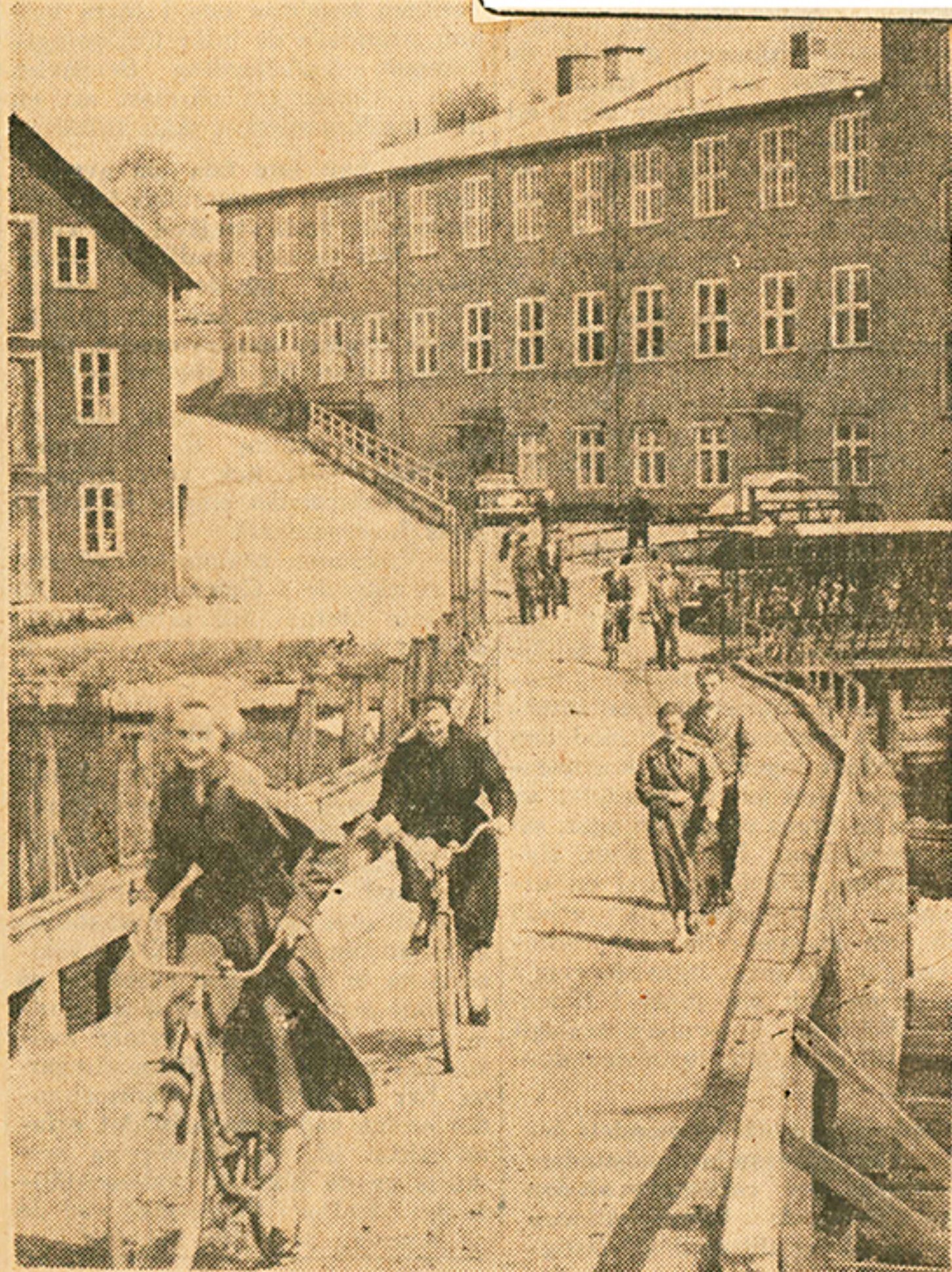
Den gamla bron över Jädraån vid yllefabriken i Järbo rimmar illa med dagens trafikkrav. Brokistorna är numera så ruttna, att brostyrelsen måst begära förbud för all biltrafik över bron hos länsstyrelsen.
