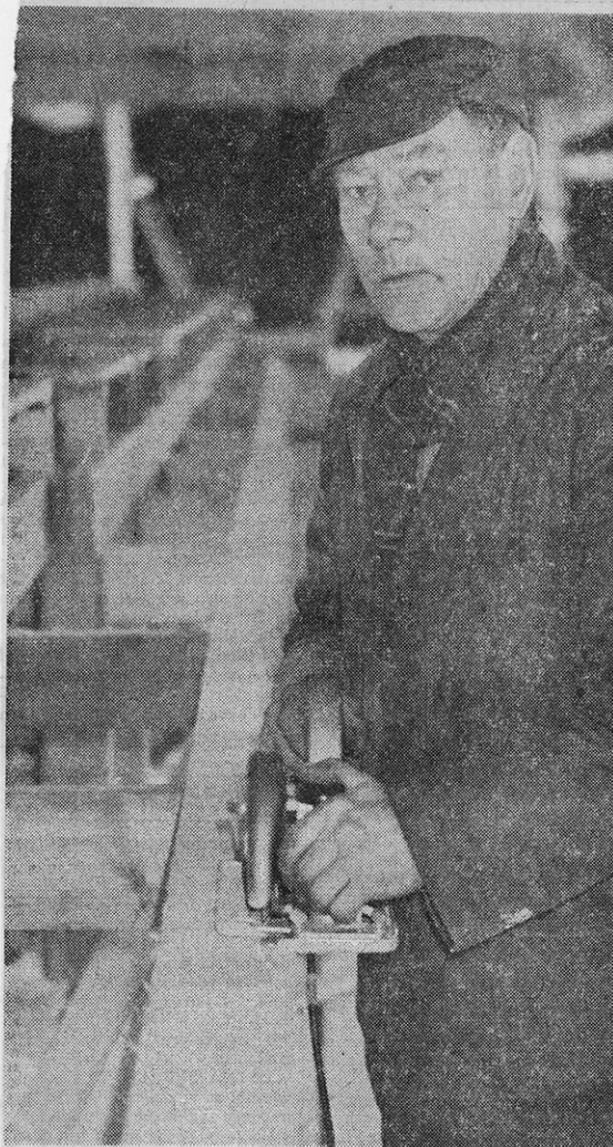
Herman Johansson, Botjärn, Järbo, arbetar med att uppföra det nya sorteringsverket vid Janssons såg i Järbo.
