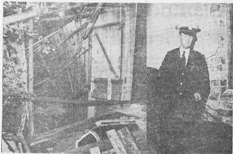
Polisman N. B. Hofvenstam konstaterar att någon skruvat bort järnstycken på en axel. T v en talande bild av förfallet.
