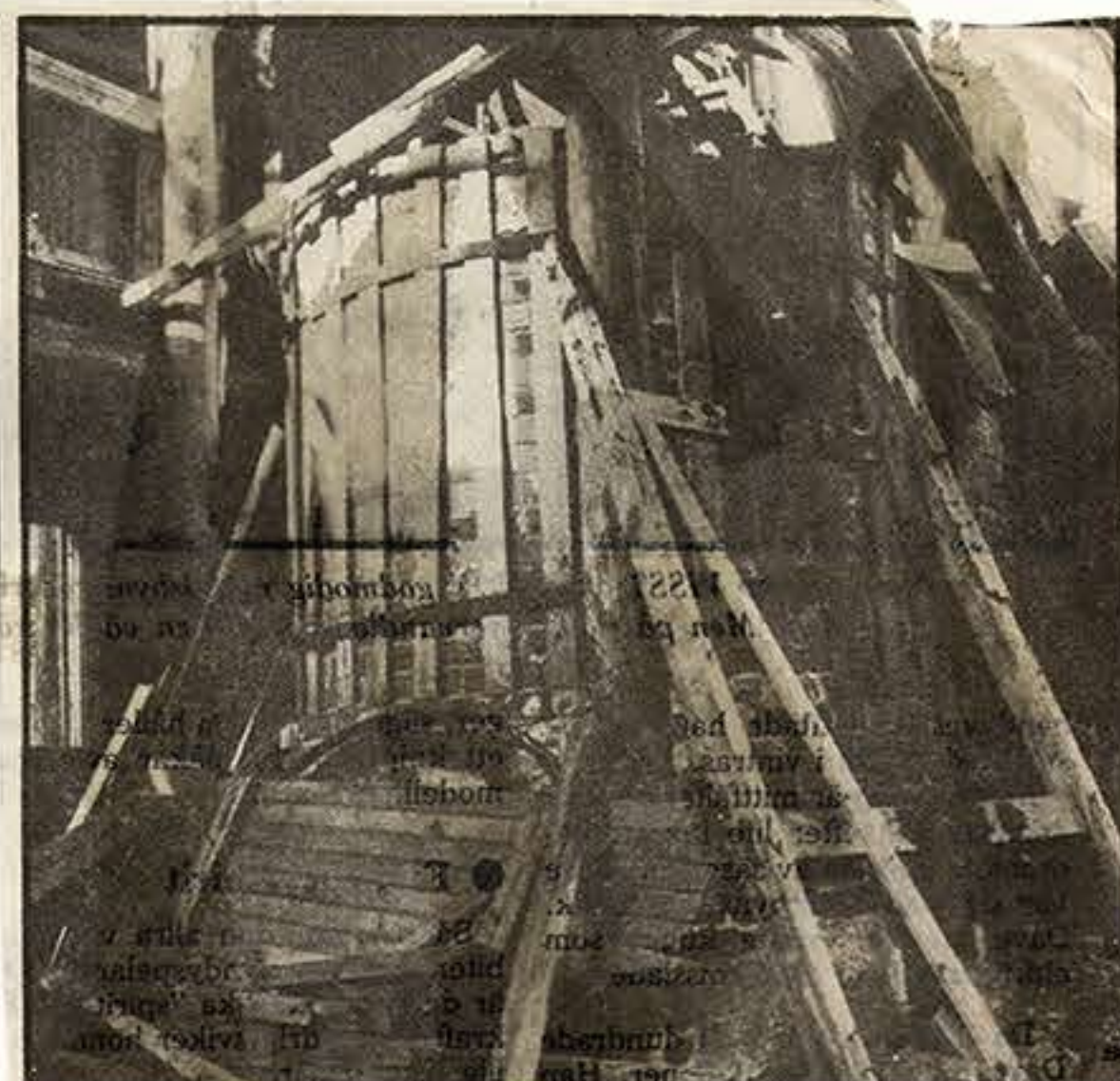
AV TJÄRFABRIKEN återstår inte mycket i dag. Taket har rasat ihop och i byggnaden finns det bara bråte kvar. Men tjärugnarna står kvar.
